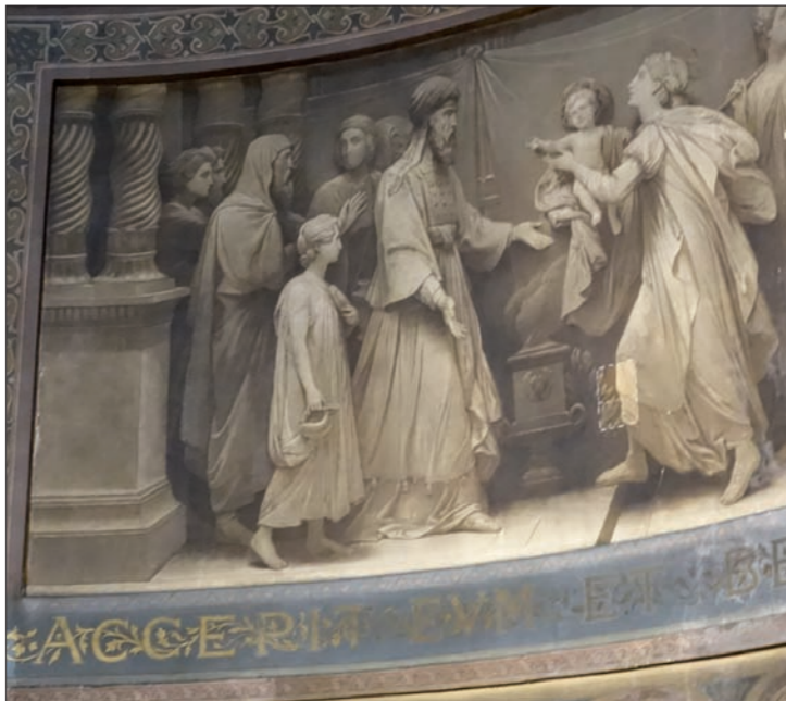
Les zones claires montrent les essais de nettoyage des peintures murales
