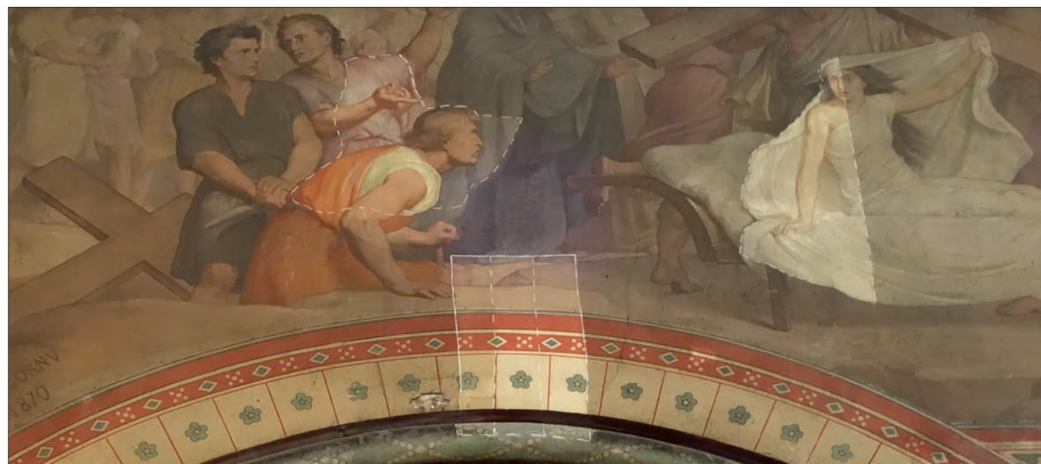
Les zones claires montrent les essais de nettoyage des peintures murales
