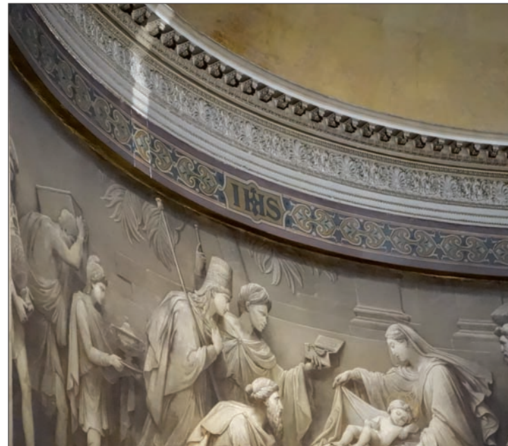
Les zones claires montrent les essais de nettoyage des peintures murales
