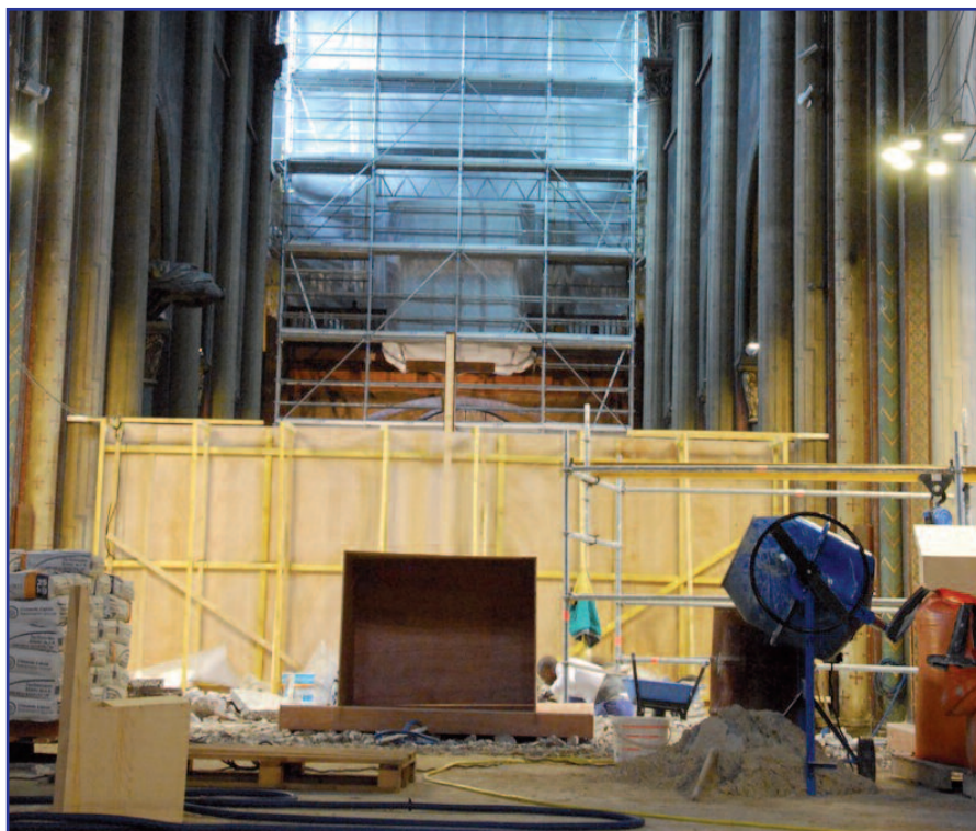
L'envers du décor. Le plateau liturgique sera livré pour Noël mais il faudra attendre le 14 février pour fêter la fin de cette première tranche de travaux du chœur. La date de la consécration de l'autel n'est pas encore fixée.
