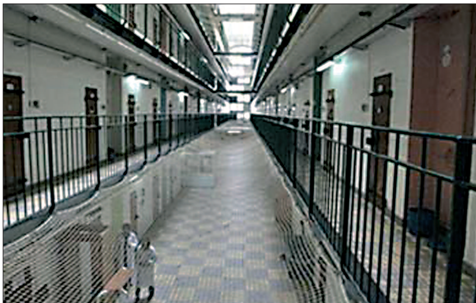
Une des trois tripales sud du grand quartier de Fresnes
